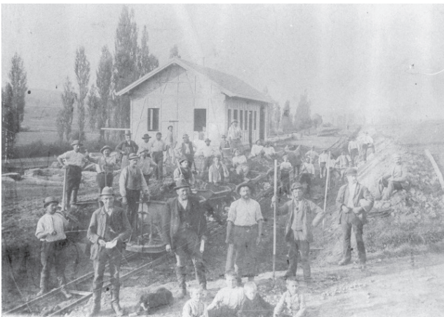
Ein Bautrupp beim Bau des Haltpunktes Weiler.
